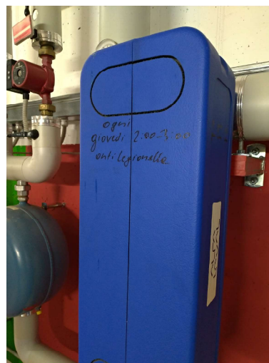
Fig. 4 – locale centrale termica: scambiatore produzione acqua calda sanitaria
